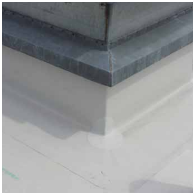
Anschlüsse an rechtwinklige Durchdringungen
